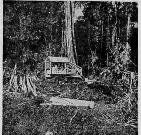
OTRO PODEROSO CARTERPILLAR D-7 dando inicio a la "operación limpieza" obsérvese el terreno, troncos, ramas y todo, pero para él no es obstáculo, sigue trabajando tranquilamente durante el día.
